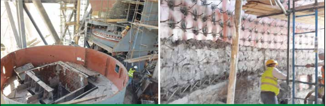
الهوت ديسك في خط الانتاج رقم (١) أثناء مرحلة التركيب
