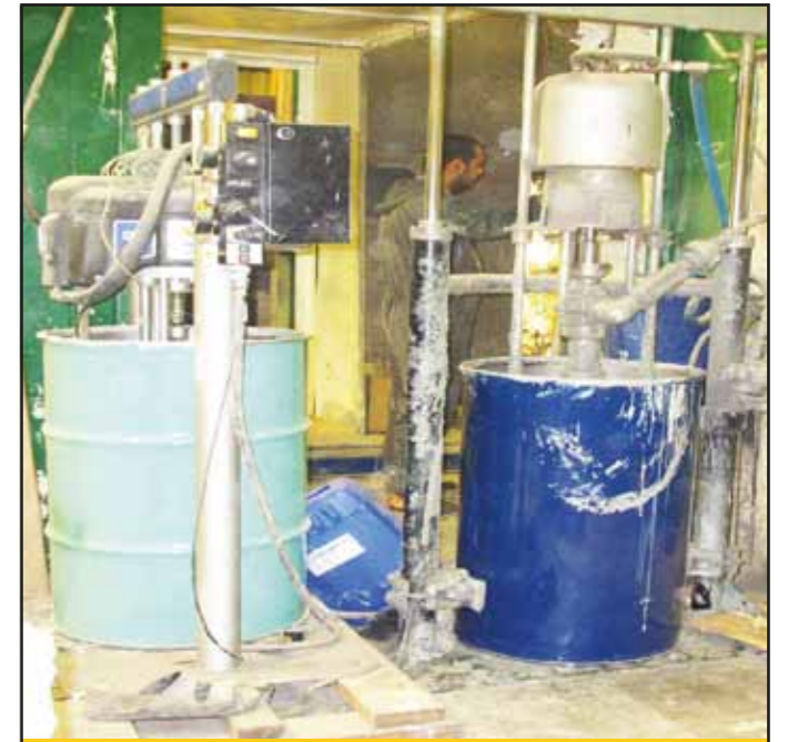
قبل تنفيذ المشروع : محطة معالجة الصرف الصناعي
